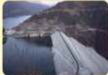
अलाकनन्दा हाइड्रो पावर Alakananda Hydro Power
