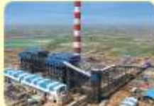
राजपुरा थर्मल पावर प्लांट Rajpura Thermal Power Plant
